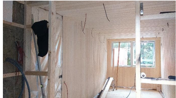
Der er trukket kabler
